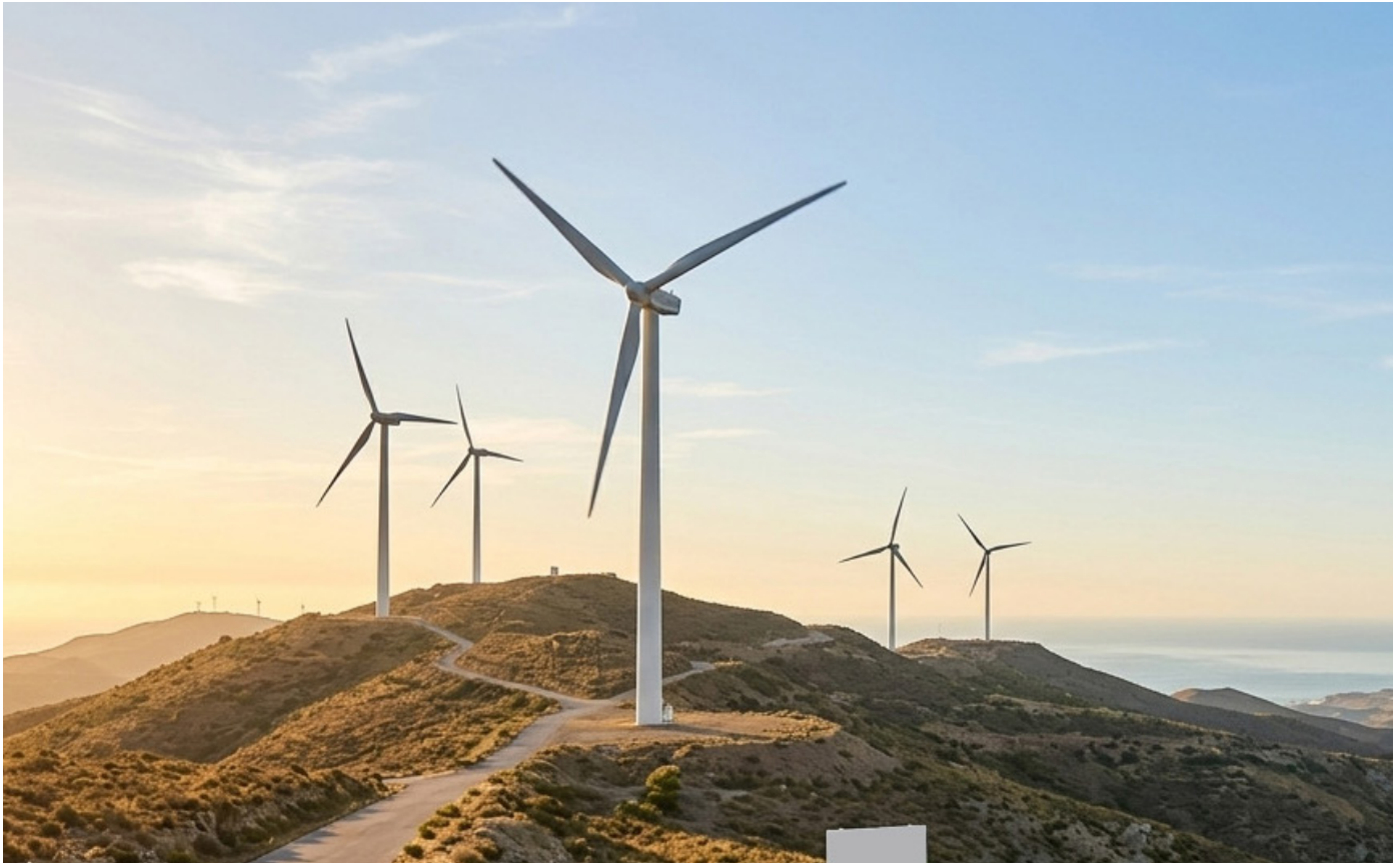
La economía verde y la explotación de energías renovables ya es visible en muchos puntos de Almería.
