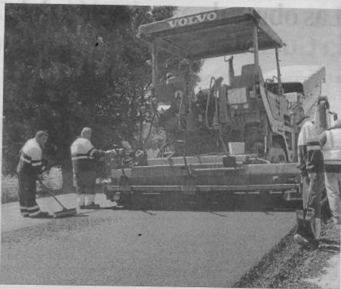
Tras cinco días de trabajos, ayer quedaron finalizadas las obras en este tramo de la A7, sentido Málaga
