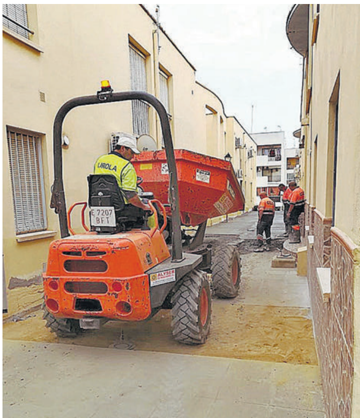
Trabajos que se están realizando en los bloques de Cuevas del Almanzora. LA VOZ
