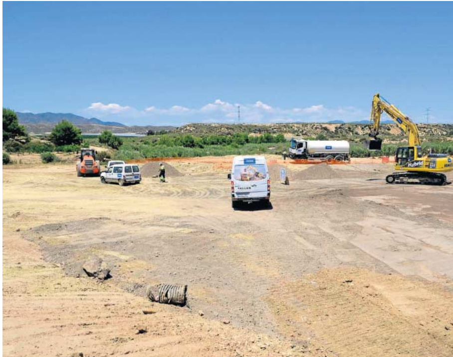
Obras del tren de Alta Velocidad en el tramo Pulpí-Vera.
