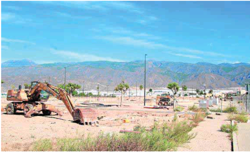
Las obras de urbanización del nuevo parque municipal de Santa María del Águila avanzan. i. a.
