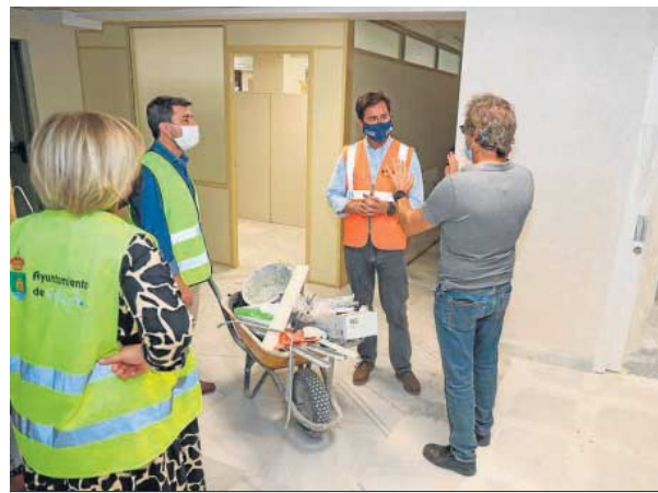
Otro momento de la visita a las obras en el Ayuntamiento.
