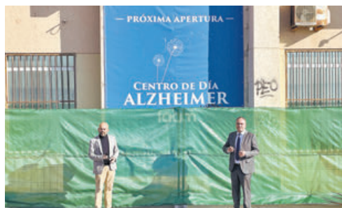
Visita a las obras del futuro centro. LA VOZ
