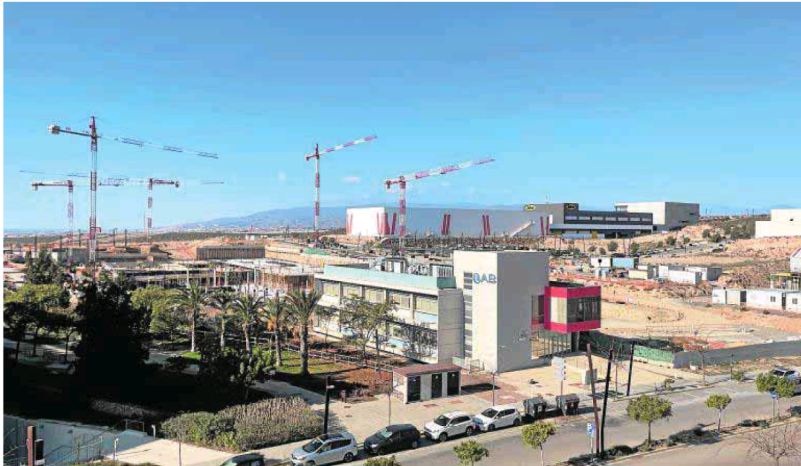
Vista de la tecnópolis con las grúas operando en suelos de reciente adquisición. R. I.
