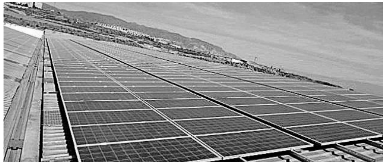
Toda la inversión se destinará a la instalación de energía solar fotovoltaica. LA VOZ
