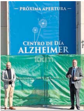
Visita a las obras.
