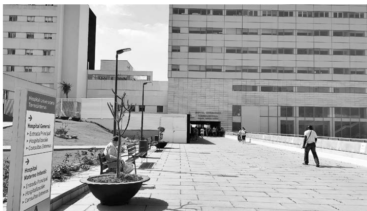
Nueva entrada del Hospital Torrecárdenas y el Materno Infantil. LA VOZ
