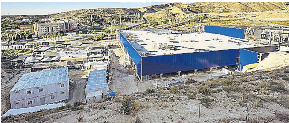
Vista general del edificio en construcción de Ikea Almería. LA VOZ
