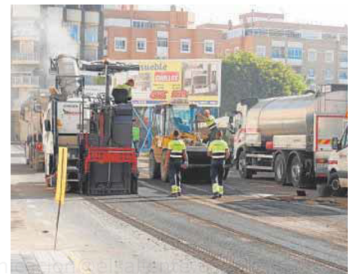
Las obras se centran en renovar el pavimento de la vía. R. I.
