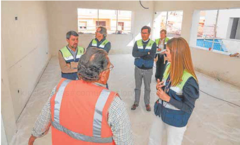
Góngora, visitando las obras del Centro de Mayores de Ejido Norte. R. L.
