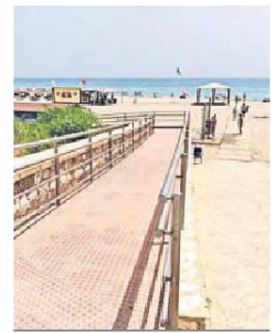
Uno de los puntos instalados.
